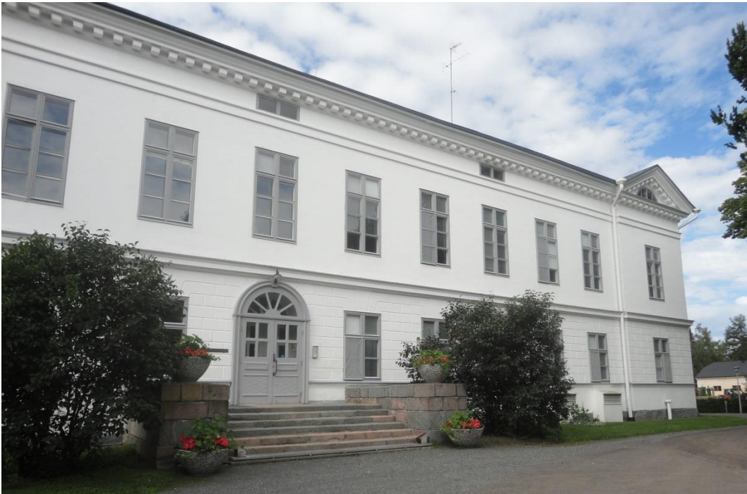
Kuva 3.6 Jokioisten kartanon päärakennus (kuva: Sweco Ympäristö Oy).
